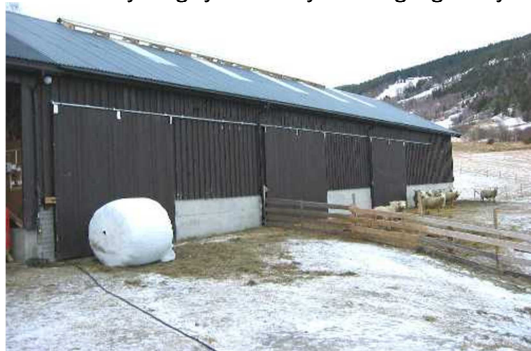
Sauefjøs med lysplater i taket og luftegarder
