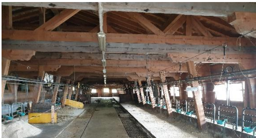
Detaljer fra fjøs, bærende trekonstruksjon, bygget må tåle stor snølast.
