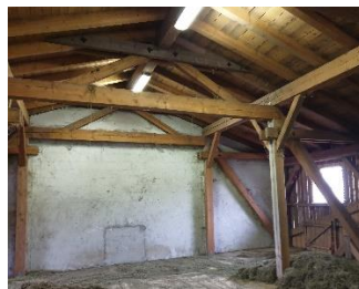
Detaljer fra fjøs, bærende trekonstruksjon, bygget må tåle stor snølast.
