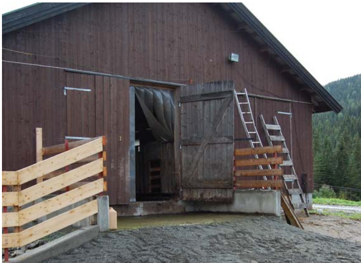
Lasterampe i enden av gjødselgang. Foto A. Bergum
